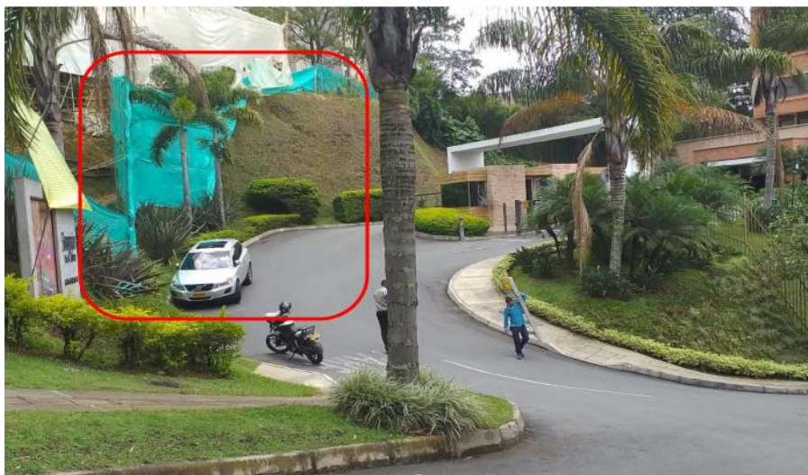
Foto 1. Condiciones antes de la intervención. Fuente. C.O.R. N° 019233 del 04 de agosto de 2020
